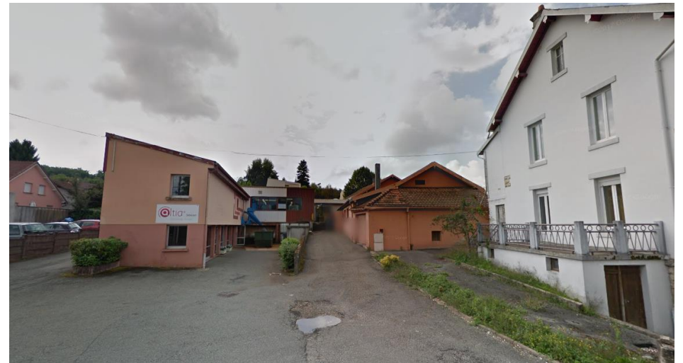
Site de l'entreprise OREXIM – Image Google Maps.
